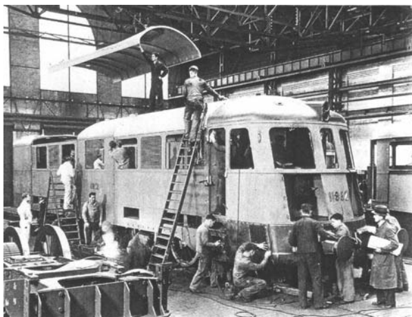
Abb. 2: Montage der Ae 8/14 11852 bei der SLM in Winterthur
